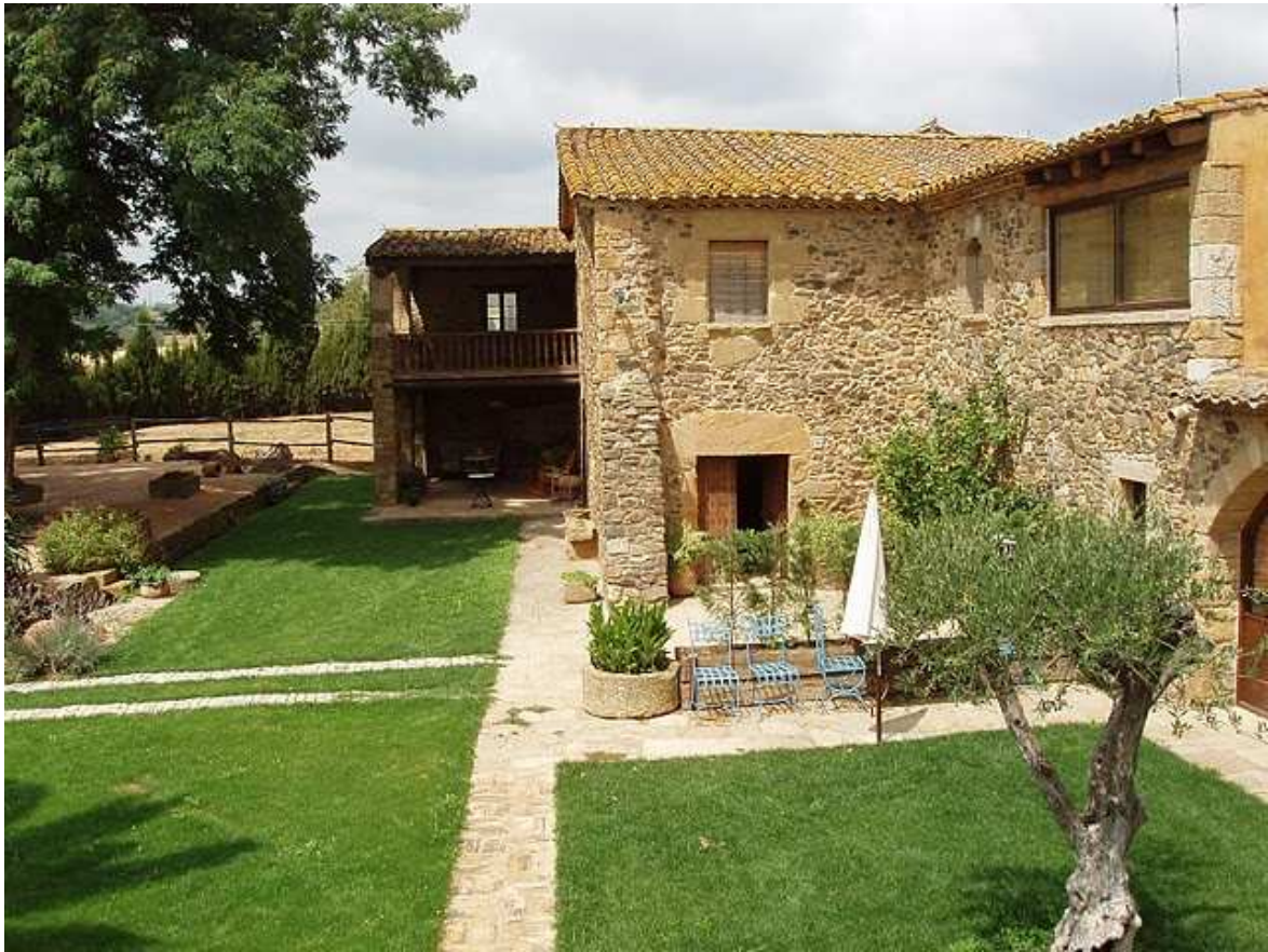
Der alte Gutshof
